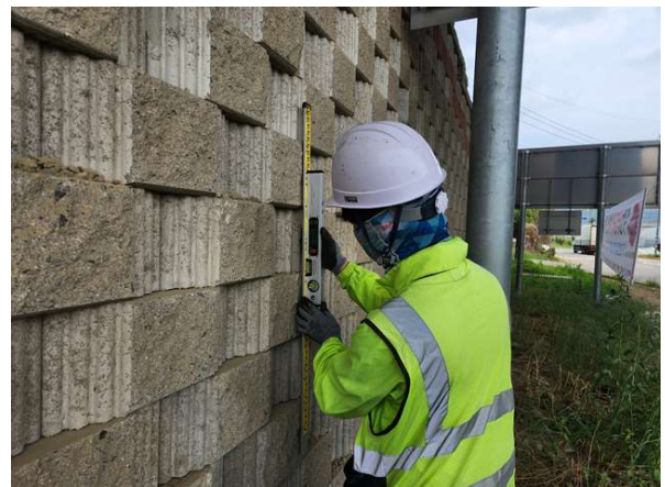
경사계를 이용한 경사도 측정
