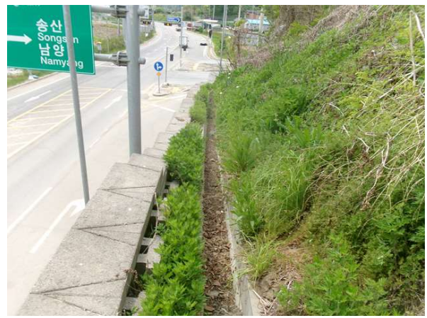
상부 배수로 전경
