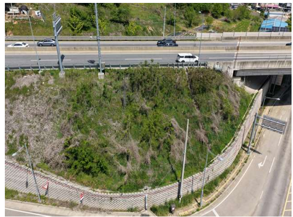
상부 성토부 전경
